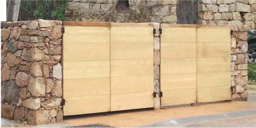
Abri conteneurs en murs de granite et portes en bois d'ipé (modèle exclusif commune de Serra di Ferro)
