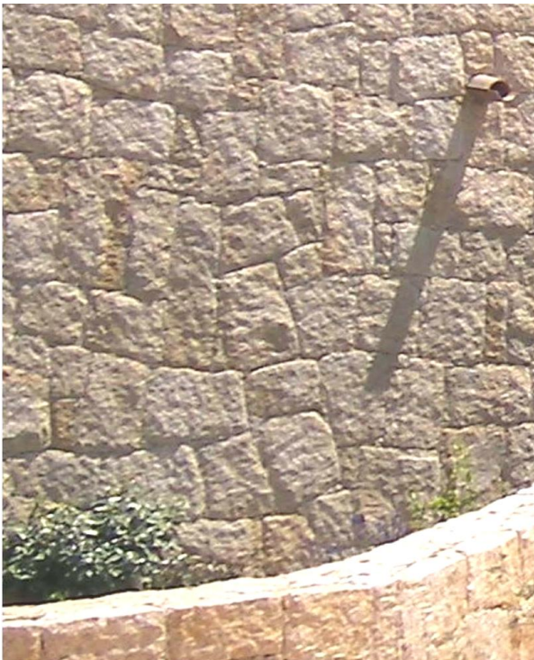
< Mur de soutènement et parapet en moellons de granite ocre-beige
